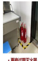
• 更换过期灭火器
