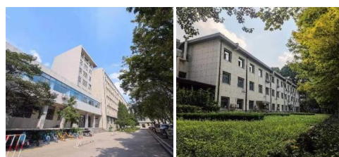
图 2. 中心校区生命南楼、老晶体楼
